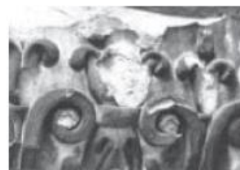
Рис. 2. Гіпсова корка на поверхні мармуру, яка відслоюється разом з карбонатною породою (Власов, Франк-Каменецкая, 2004).
